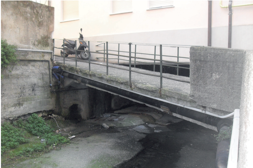
Figura 4: passerella di collegamento tra via Oliveto e Via Rossetti
