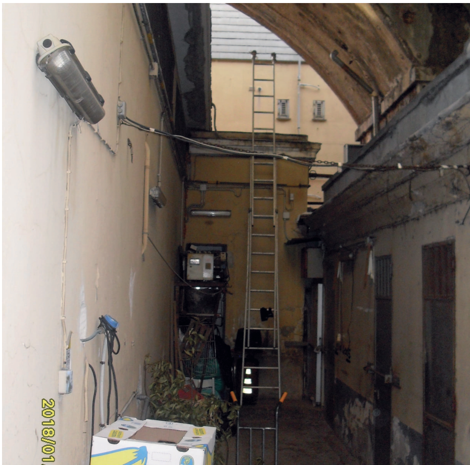
Figura 3: Edificio “Celle frigorifere” (a destra), adiacente all’edificio “Mercato”
